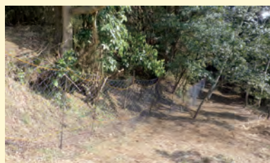
横野地域 地域防護柵の整備
