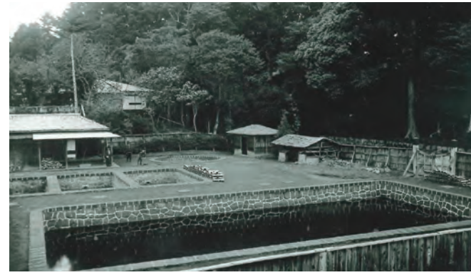
曾屋水道創設期の浄水施設
