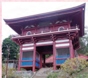
「東光寺薬師堂山門」は安永3年に建造
