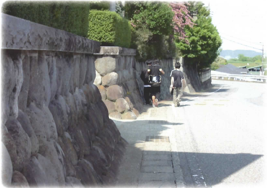
石垣が続く渋沢下の庭地区
