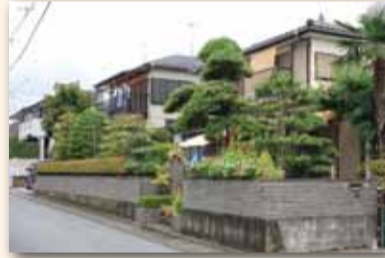
塀の石材と石垣、自然の樹木の配置が住宅地の景観を引き立てています。(堀川・Y邸)
