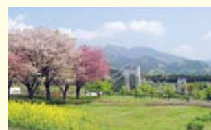
地域景観拠点に登録されている 県立秦野戸川公園「風の吊り橋」
