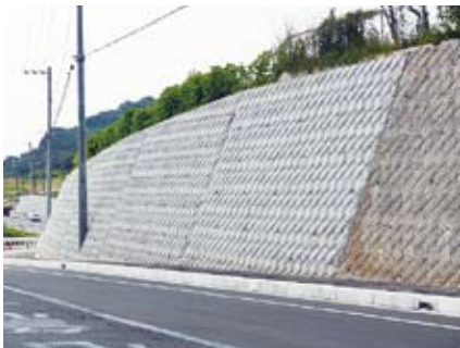
◎化粧仕上げを行っているものの、さらに検討したい法面の仕上げ
