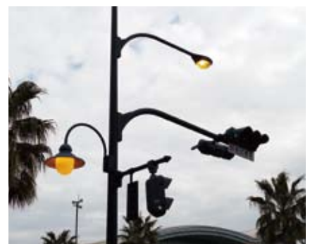
○目的の異なる複数の設備類を共架させた機能的な鉄柱 (浦安市)
