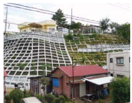
△原状回復すべき植栽等による修景計画が求められる急傾斜崩壊対策工事
