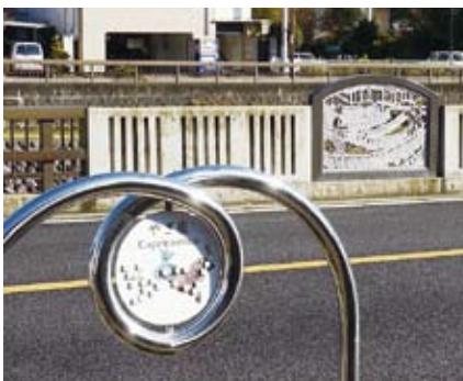
△道路の両側で統一感が必要な柵
