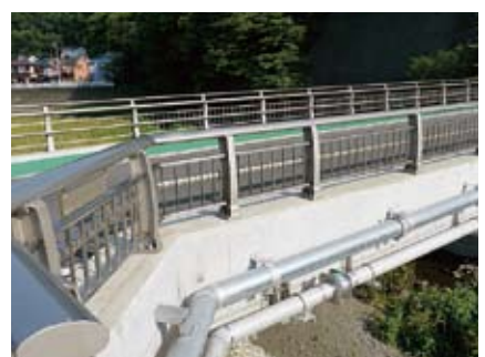
◎機能に着目し、すっきりとした橋梁
