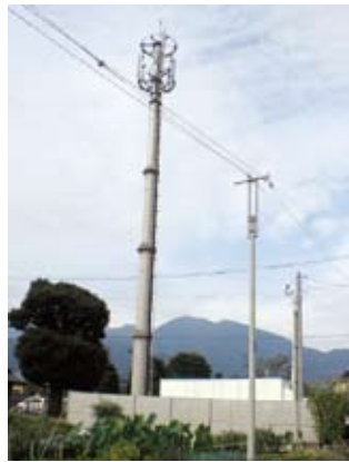
○10YR6.0/1.0の色彩を使用した鋼管柱型の電波塔
