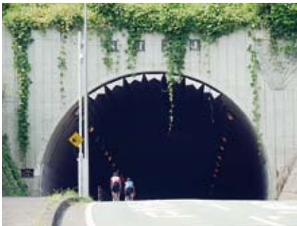
◎化粧仕上げと植栽による自然の修景が進むトンネル抗口（大井町）
