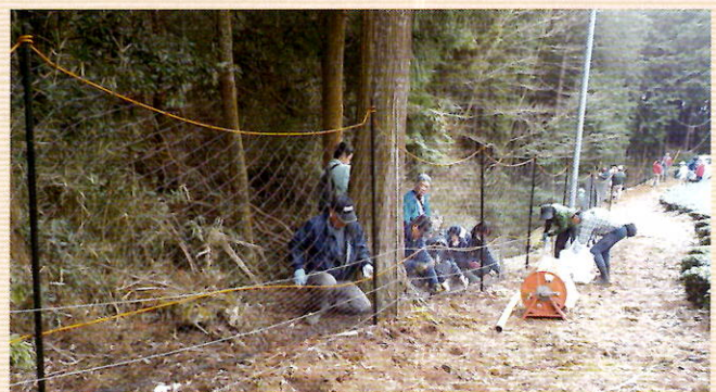
▲ 設置作業の様子
