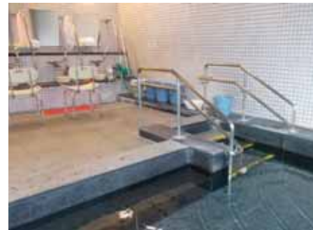
浴室、洗い場と浴槽へ入る階段
