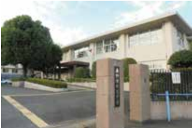
4月1日から下水道事業の窓口・料金業務や汚水管・雨水管の維持管理部門は水道局庁舎(曾屋830番地1)へ移転します。
