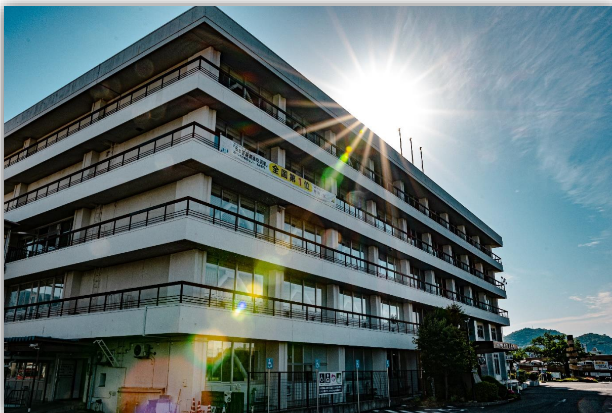
秦野市役所本庁舎
