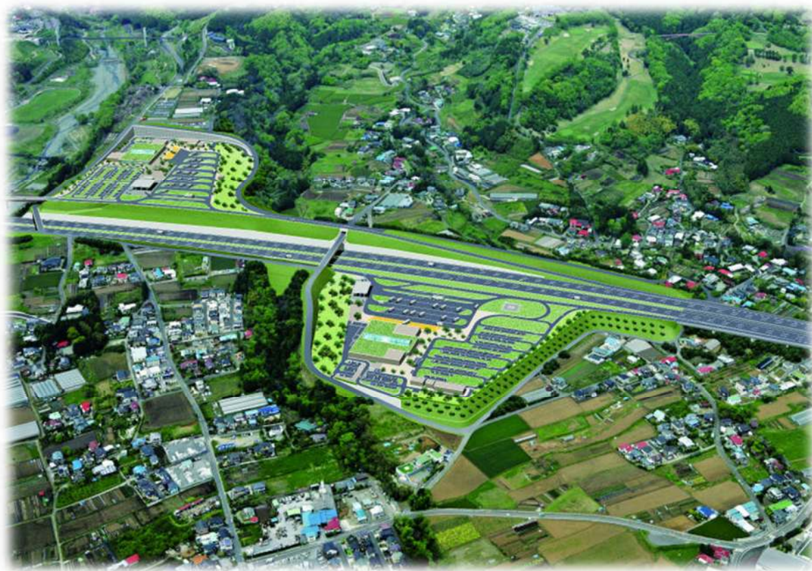
H32年度開通予定の新東名高速道路と（仮称）秦野サービスエリア
