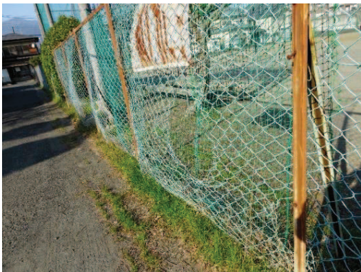
ネットフェンスの老朽化
