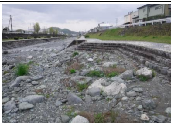
緑風橋付近右岸(接写)
