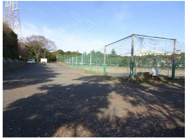
消えかけている駐車場ライン
