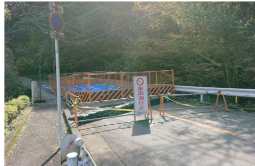
市道18号線の復旧
