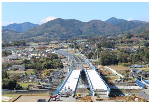
整備が進む新東名高速道路
