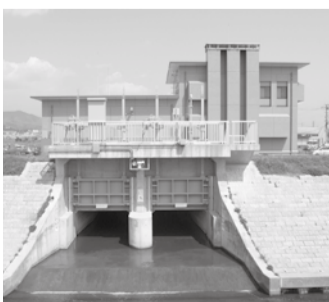
集中豪雨時などに稼働する大根川ポンプ場
