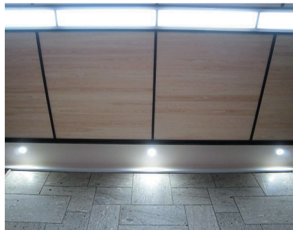
秦野産材を使用した天井とLED照明
