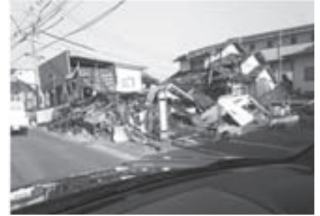
熊本地震で倒壊した家屋 (写真は熊本県益城町)
