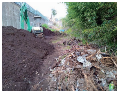
暗きよ上部のわずかに約30平方メートルで4トントラック55台分にもなった土砂など
