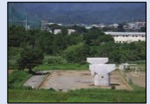
▲ 中津川橋橋脚
