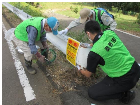
啓発看板の設置
