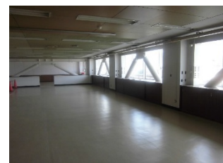
鉄骨ブレース写真
