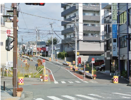
整備が進む県道705号の様子
