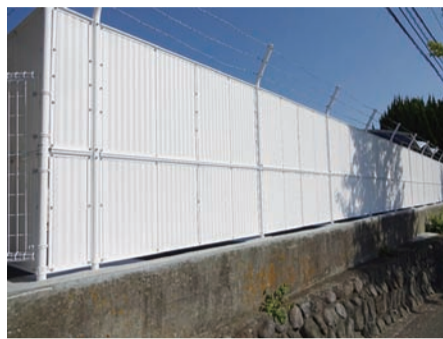
ブロック塀から改修された本町中学校のフェンス
