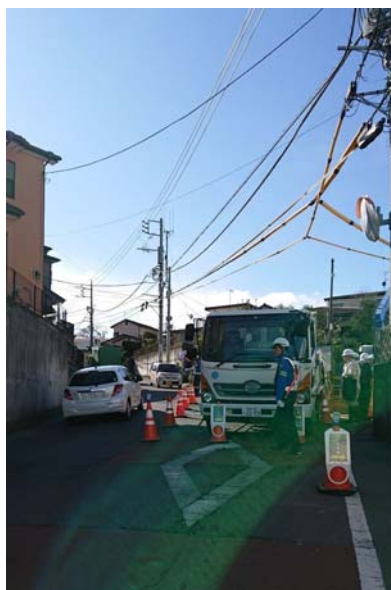
写真-4 道路規制状況
