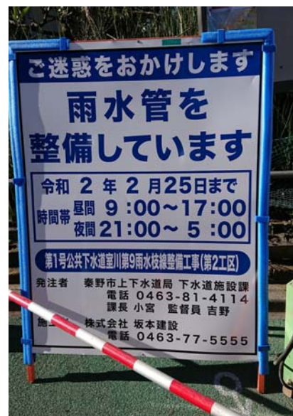
写真-5 工事看板
