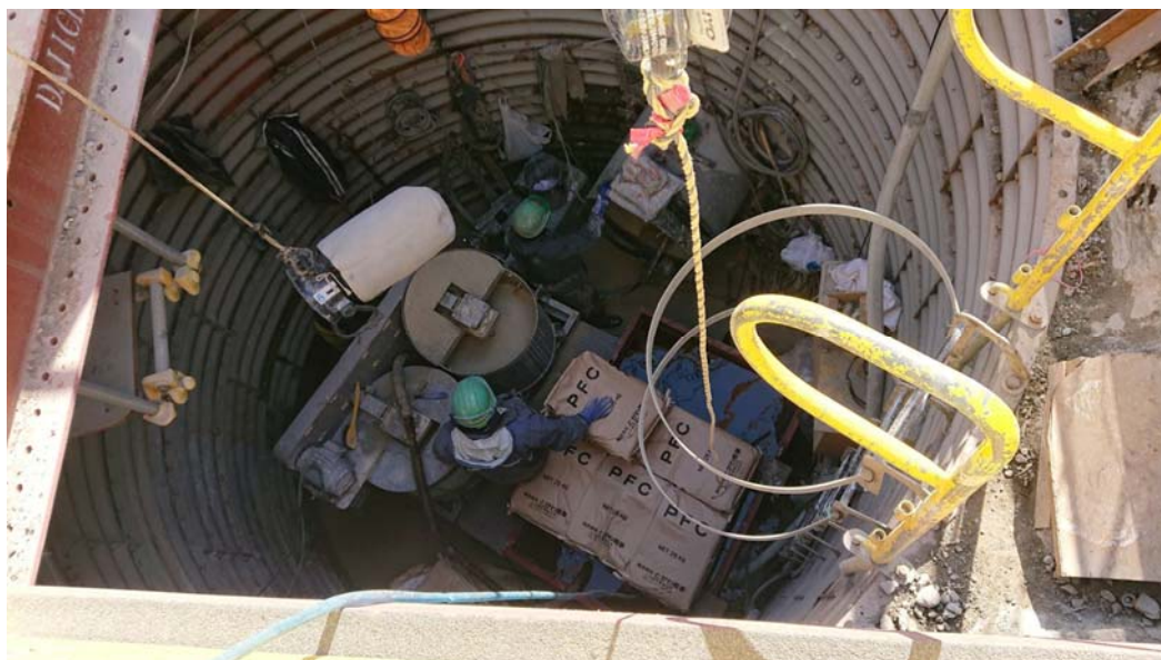
写真-1 裏込め注入作業風景（監査実施時）
