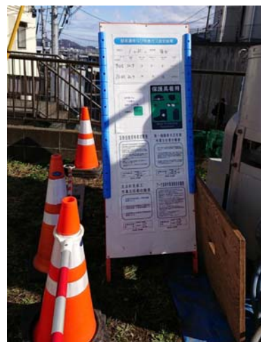
写真-3 工事看板
