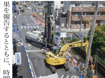
塩貝橋付近の下水道工事の様子
