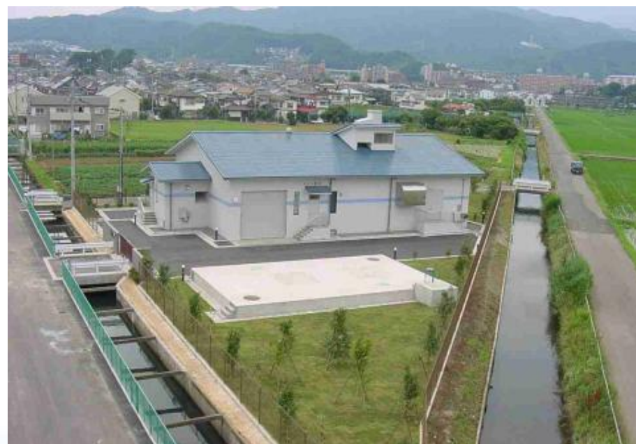
中継ポンプ場（鶴巻中継ポンプ場）
