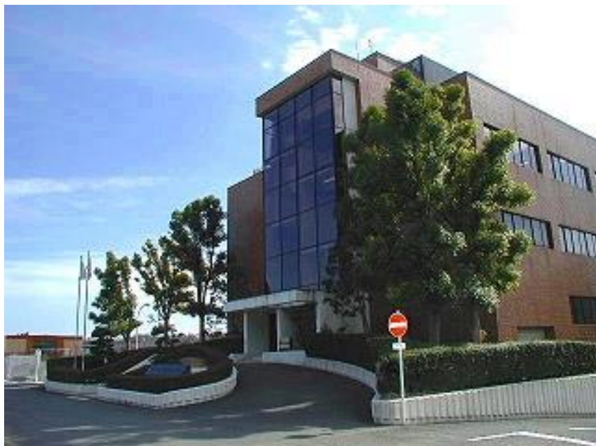
下水処理場（浄水管理センター）
