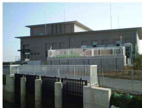
大根川ポンプ場
