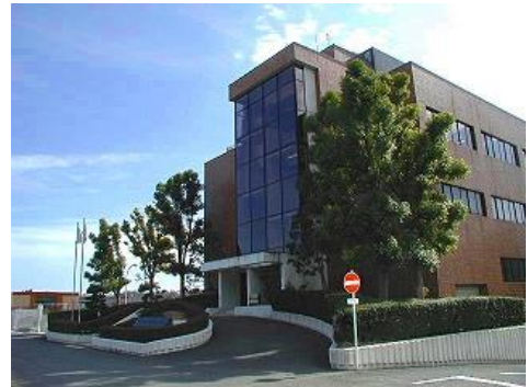
浄水管理センター
