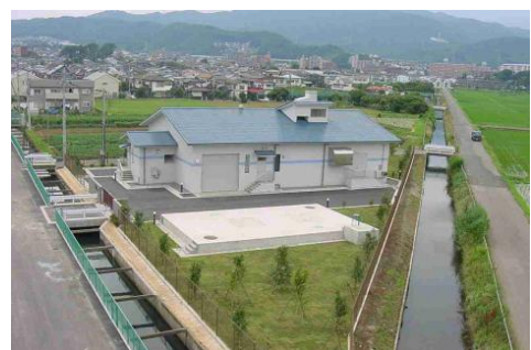
鶴巻中継ポンプ場
