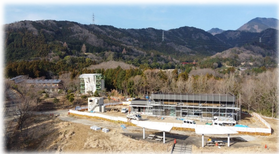
オープンに向けて着々と工事が進む「はだの丹沢クライミングパーク」
