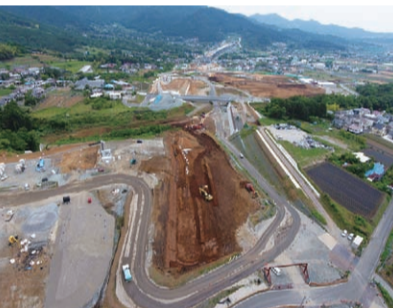
健全な市街地形成と公共の福祉の増強を (写真は、(仮称) 秦野サービスエリア工事現場)
