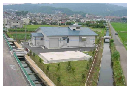
鶴巻中継ポンプ場
