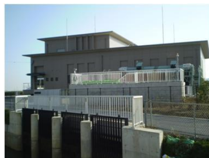
大根川ポンプ場
