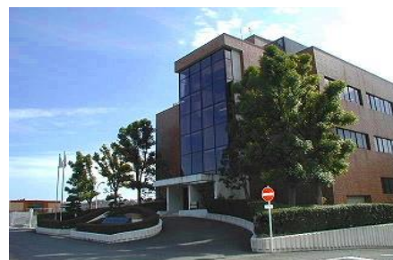
浄水管理センター
