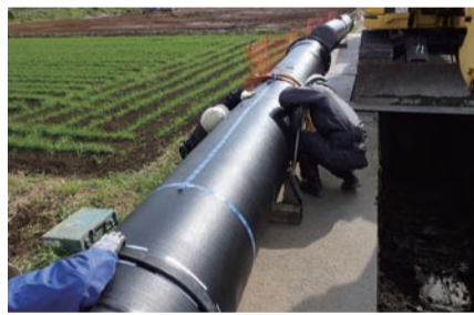
水道幹線管路耐震化工事の様子
