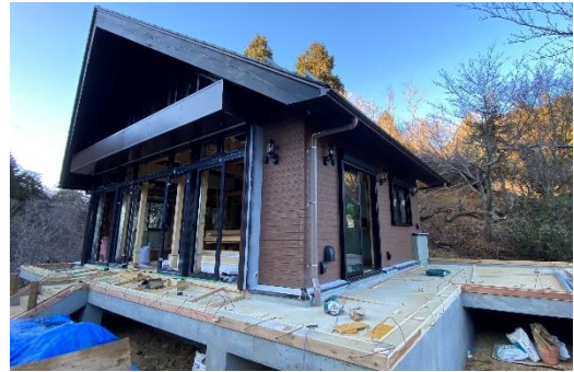
建設工事中のヤビツ峠レストハウス
