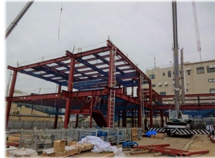
建設が進む学校給食センター
