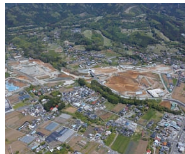
地域資源を最大限生かしたまちづくりを (写真は、(仮称)秦野サービスエリア工事の様子)
