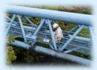
水管橋の点検の様子
