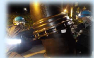
水道管(直径60cm)の更新・耐震化工事の様子
