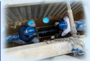
水道管(直径20cm)の更新・耐震化工事の様子
