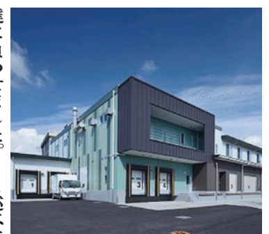
給食センターの建設費は約18億円
