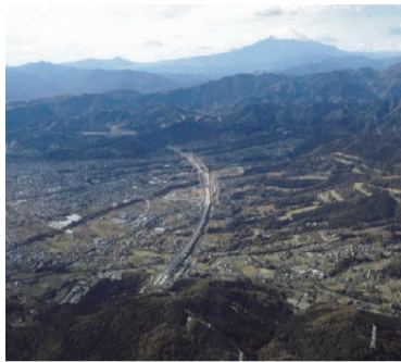
整備が進む戸川地区
