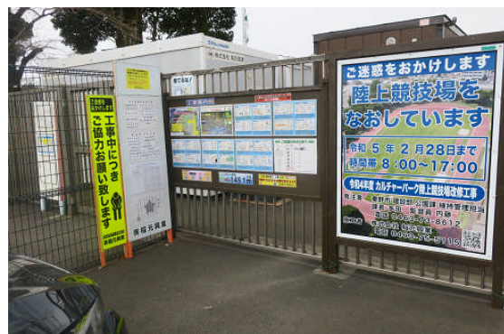
写真-7 工事告知看板
