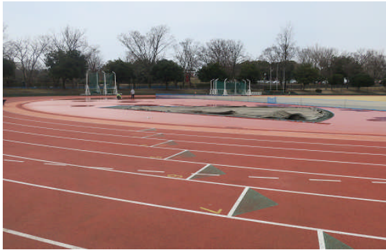
写真-3 A・Bゾーン全天候型舗装
