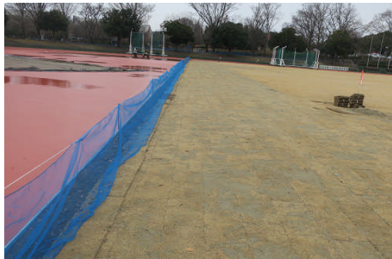
写真-5 全天候型舗装と天然芝舗装境界部
