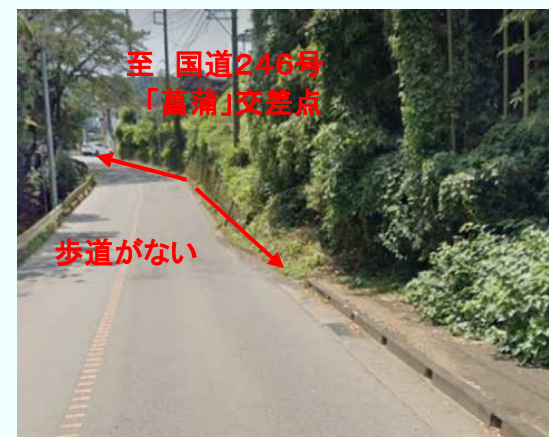
「菖蒲」の交差点を左折した道路には、一部歩道がない
