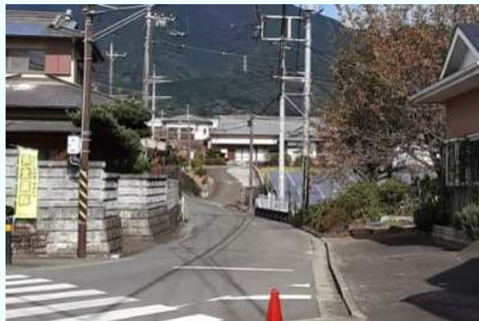
道幅が狭く、通勤時間帯の交通量が多いため危険
