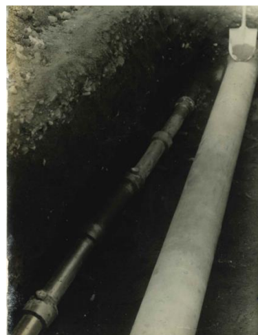
水道管埋設写真 左側：陶管 右側：鉄管
