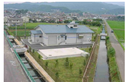
鶴巻中継ポンプ場
