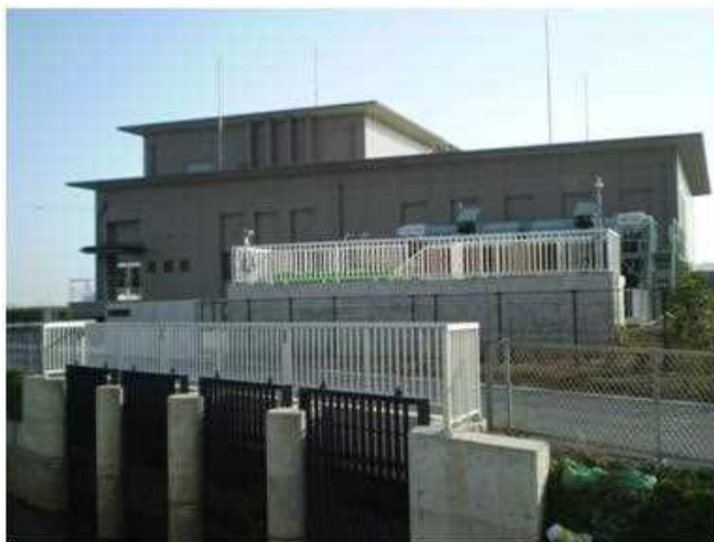
大根川ポンプ場 (平成 24 年 11 月供用開始)
