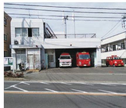
改修が予定されている消防署大根分署
