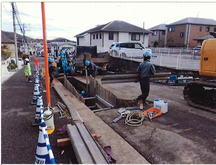
掘削施工状況 軽量鋼矢板建込工法
