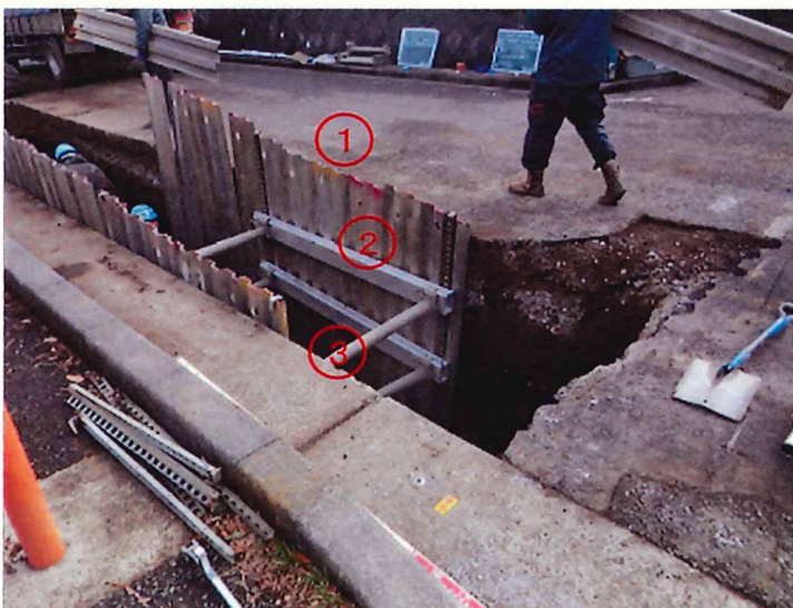
施工状況 ①：軽量鋼矢板 ②：腹起こし(アルミ製) ③：切梁(アルミ製・水圧式)
