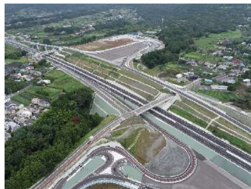
秦野区間が開通した新東名高速道路
