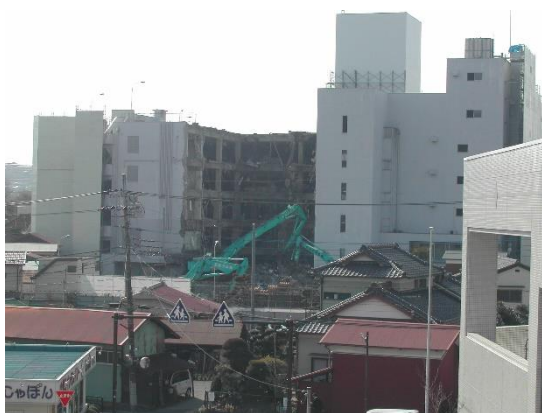
旧「忠実屋」建物解体工事 平成 19(2007)年
