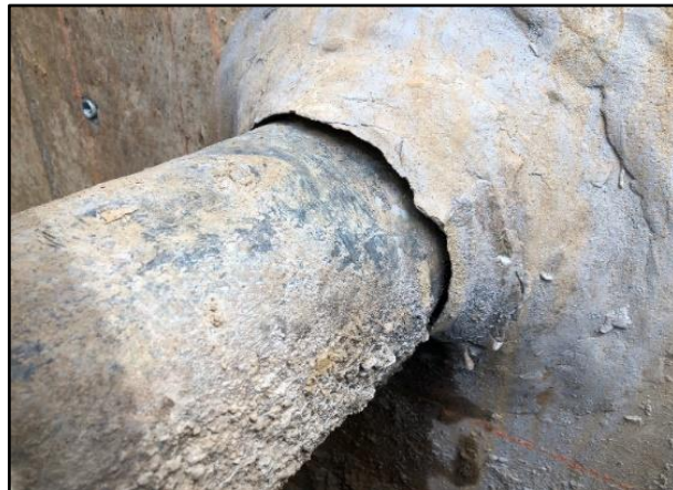
図 3-3 ボックスカルバート貫通部分
