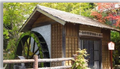
↑ 水車小屋（緑水庵に併設） 平成元（1989）年建築。
