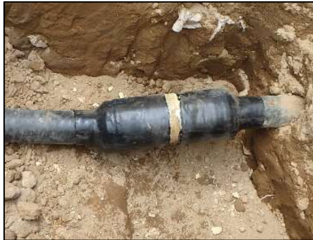
図 7-4 富士見の湯側土中埋設部分の溶接箇所
