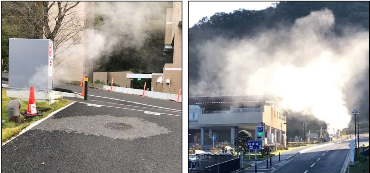
図 2-3 排気口から蒸気が上がっている状態（富士見の湯敷地内）
