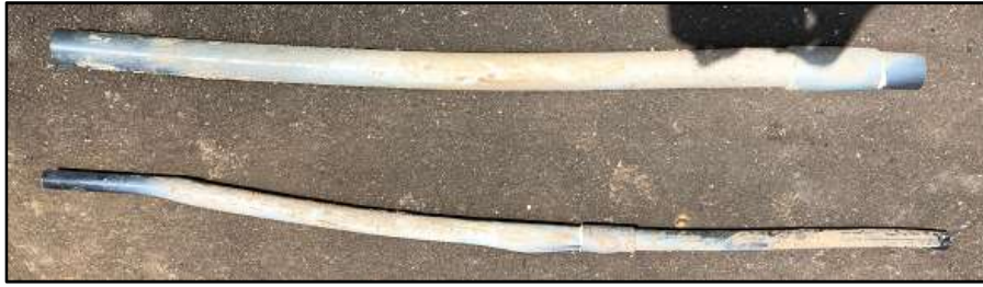
図 3-7 給水管の変形、破損
