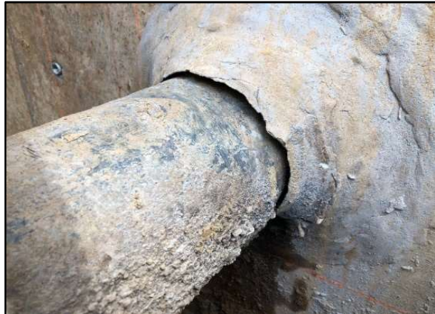
図 3-4 ボックスカルバート貫通部分
